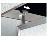
外枠のストッパーをずらして内枠のアーム ごと取り外して下さい。
