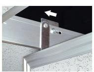
内枠のアームを外枠の切り欠き部に合せて、 外枠のストッパーを所定の位置に戻し、取り 付けて下さい。
